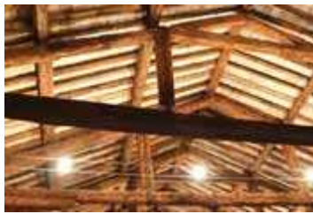
(d) Type IV construction
